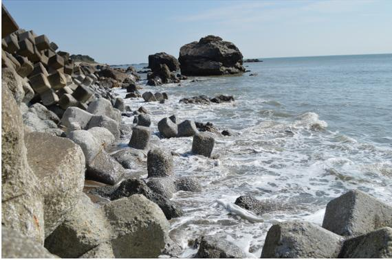
写真1. 磨耗の進むテトラポットと大ズメ岩。
