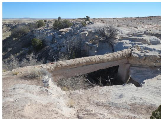
図 8. Agate Bridge. 崩落しないようにコンクリートで支えられている。
